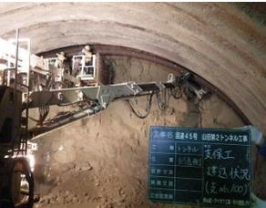
▲トンネルの形状に合わせた鋼製の枠を周囲に組み込み、枠の間に金網を取付け、地山の落下防止を図ります。
