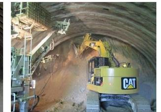
▲発破後に落下しそうな石、浮いた石を削岩機で落とす、切羽表面を整えます。
