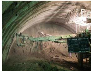
▲コンクリートをトンネルの壁面に吹き付けて、トンネルが崩れないように固めます。
