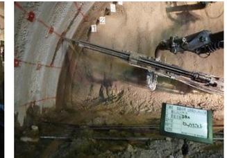
▲トンネルの壁面から放射状にロックボルト(長さ3~6mの鉄製の棒)を打込み、トンネルと地山を一体化させ、補強します。
